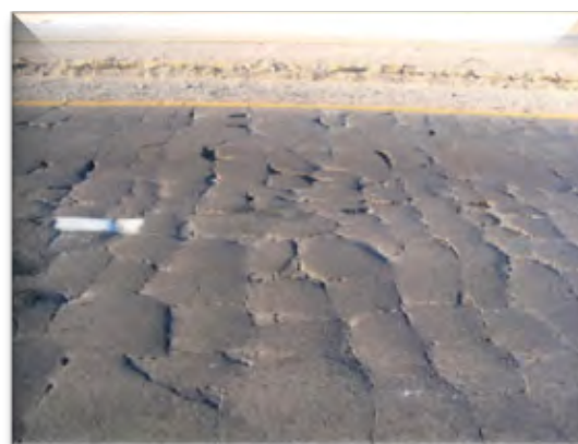
شکل ۳- ترک‌های بلوکی
