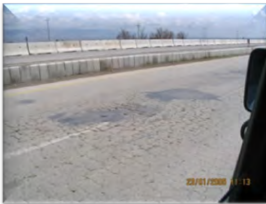
شکل ۱- ترک پوست سوسماری
